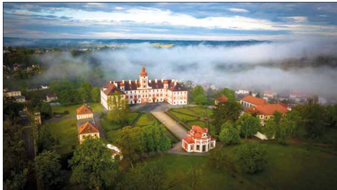
Zámek Mnichovo Hradiště
