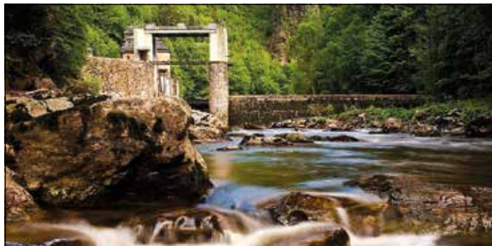
Vodní elektrárna Spálov
