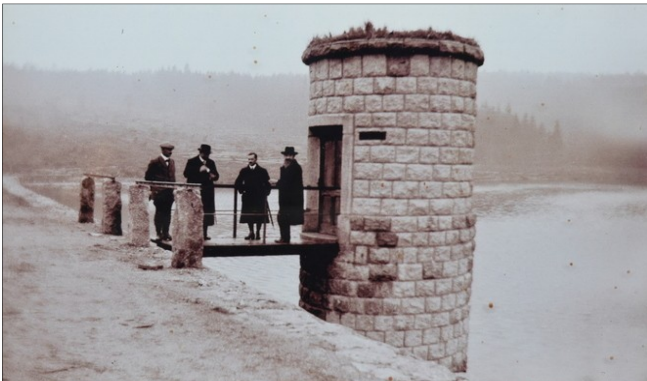
Vstup do šoupátkové věže z koruny hráze
