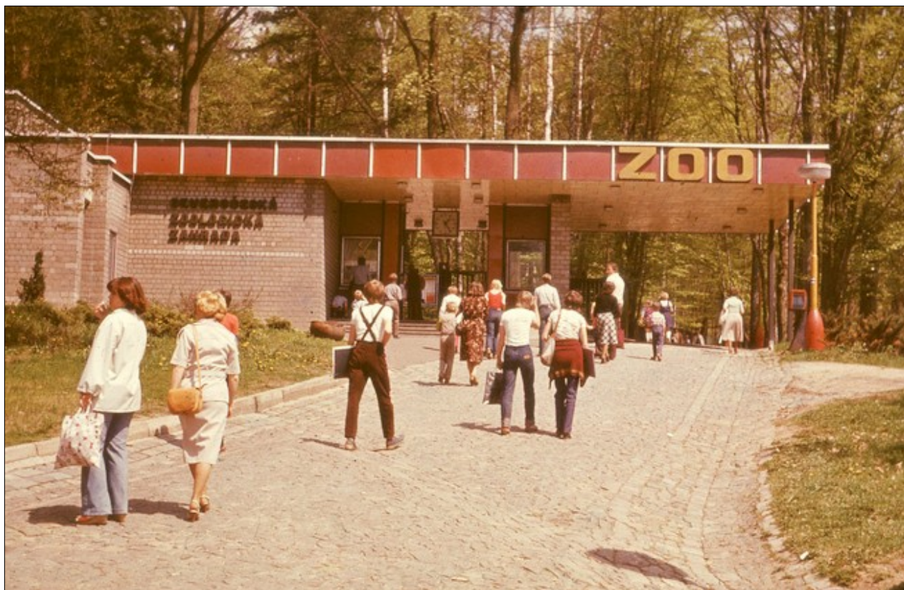
Dolní vstup byl otevřen v roce 1978
