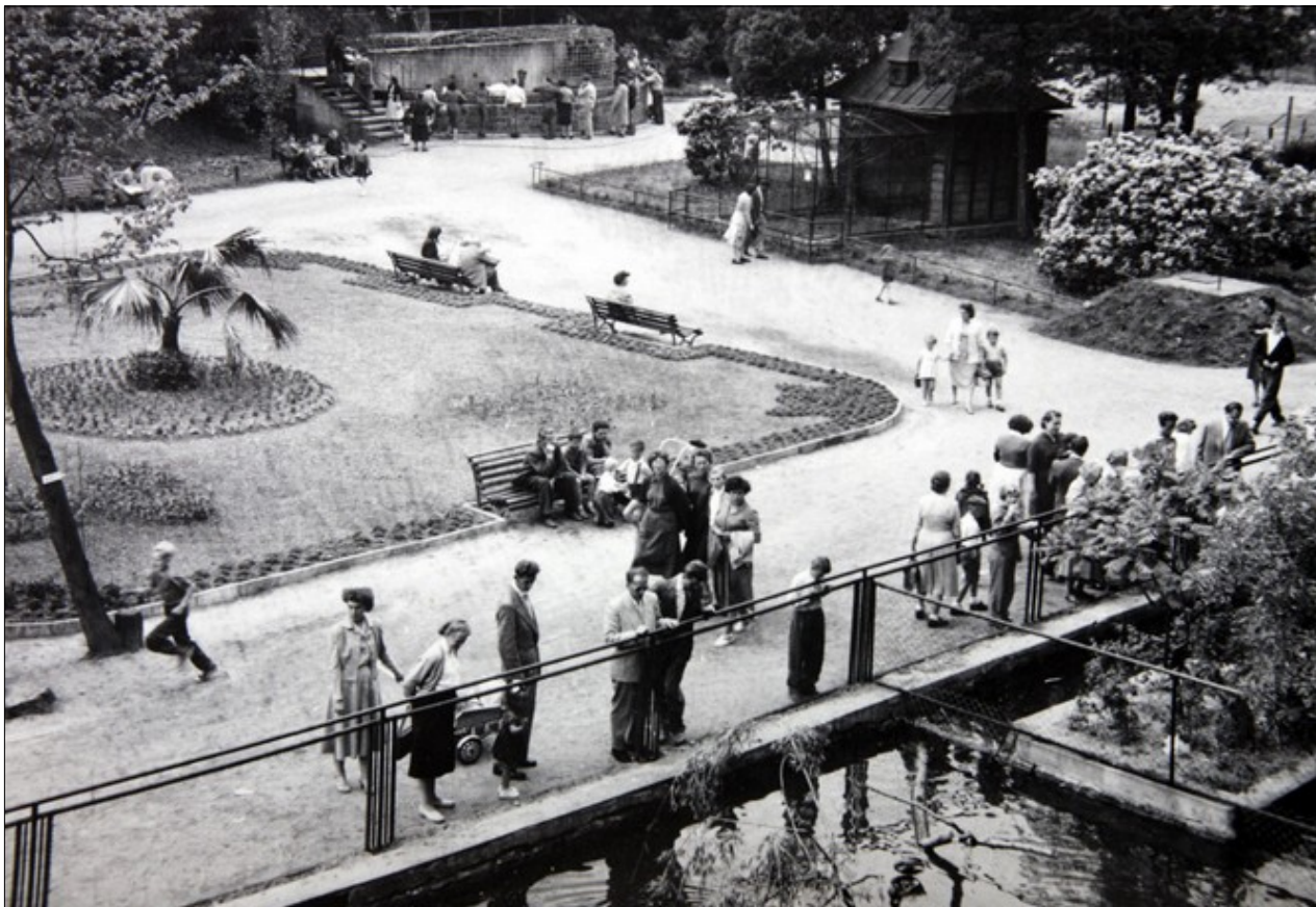
Parková úprava spodní části po povodni v roce 1958
