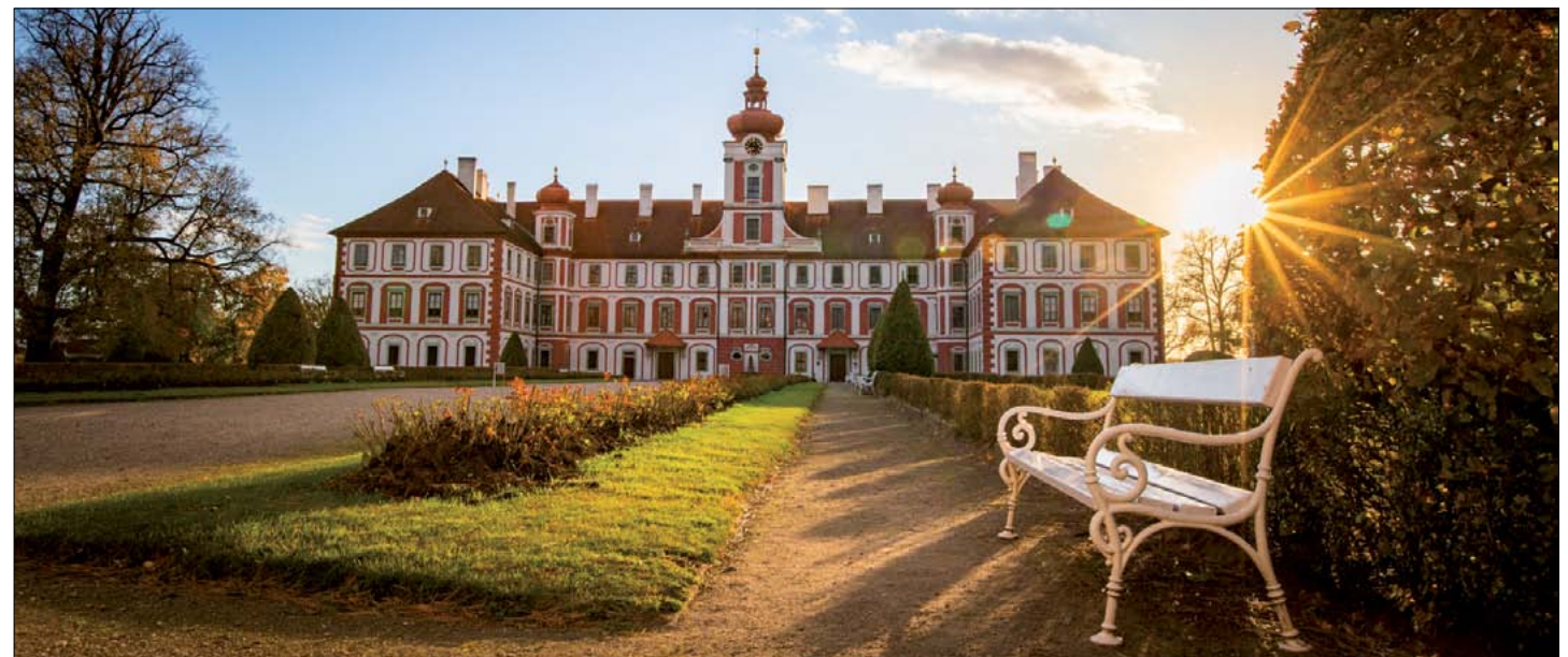
Zámek Mnichovo Hradiště
