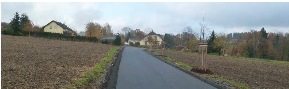
Stav na stavbě dne 6.11. 2021 (pohled na Dalešice)
