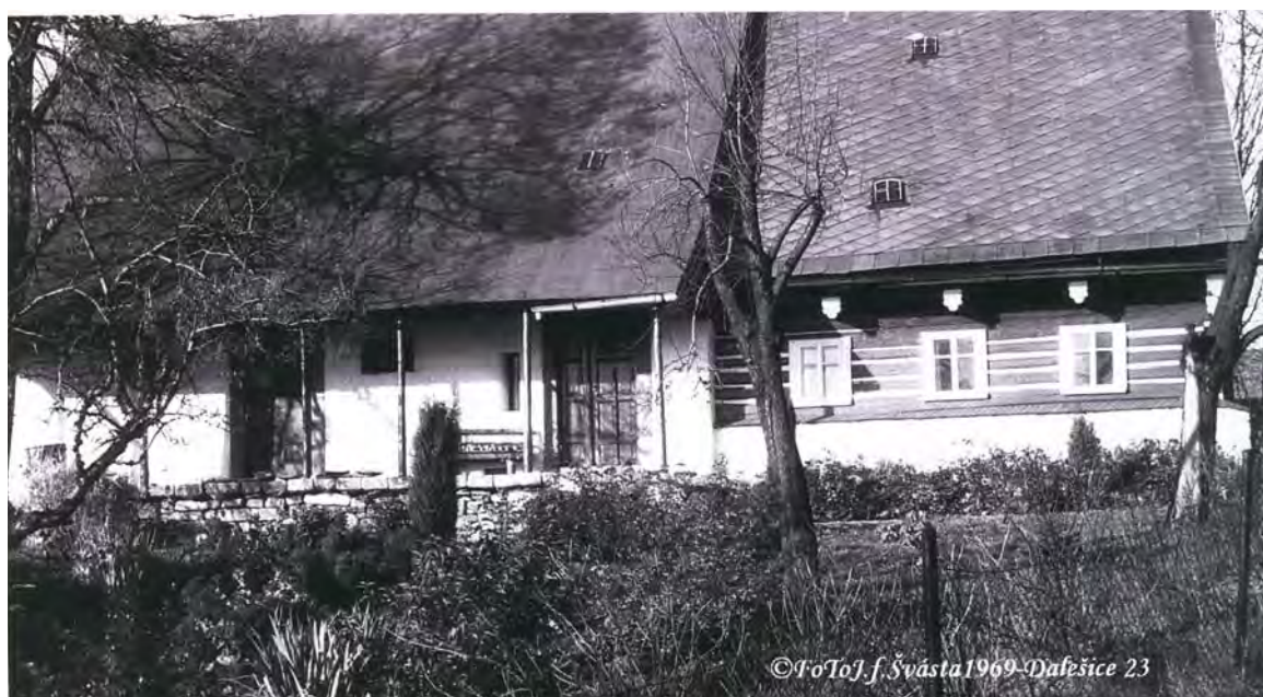
Stav domu č.p. 23 v roce 1969 (autor J. Švásta, Maršovice)
