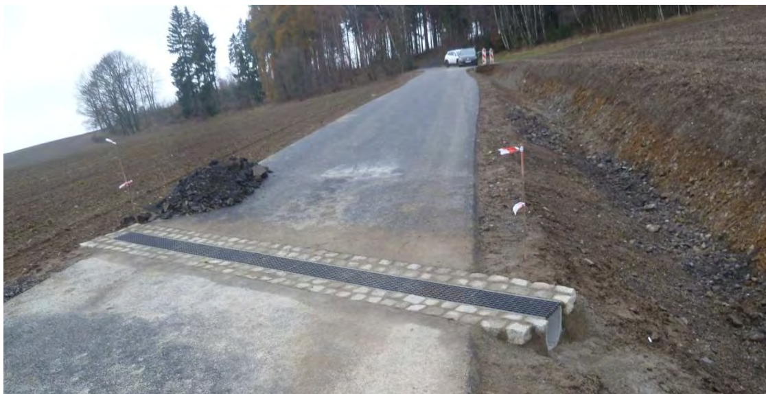
Příčný odvodňovací betonový žlab 28.11.2022
