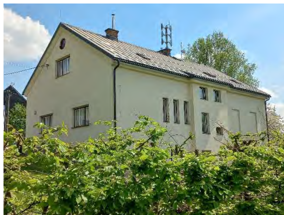
Oprava střechy na budově OÚ
