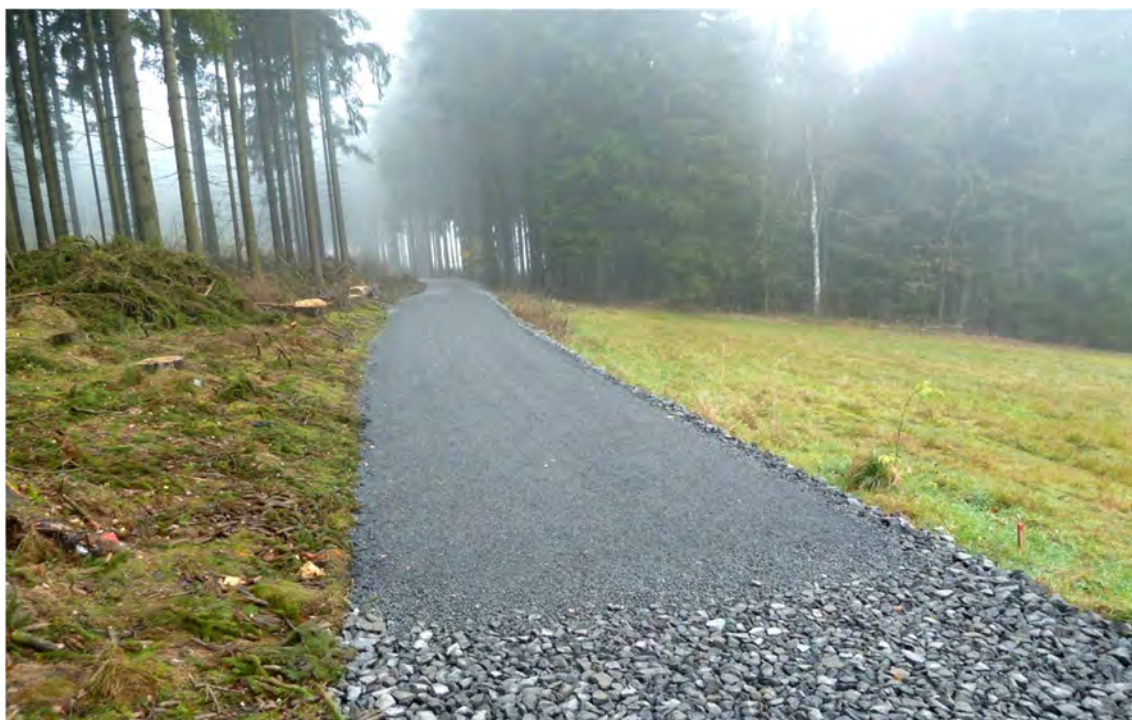
Ukončení obnovy cesty u Maršovic (pohled na Dalešickou stranu) 15.11.2022
