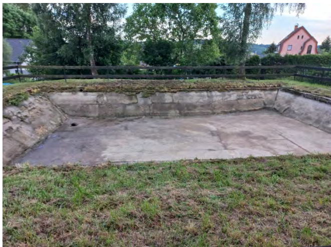
Horní hasičská nádrž před opravou
