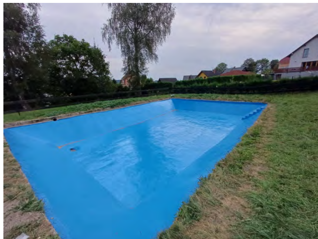
Horní hasičská nádrž po opravě
